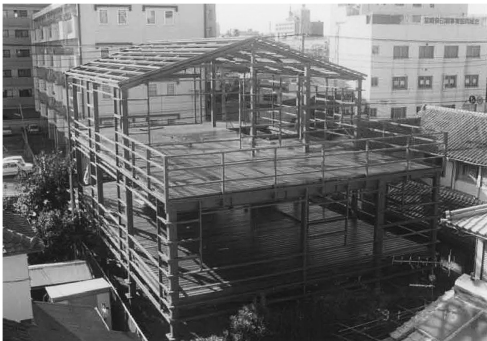
●平成3年10月15日 会館建設中の様子
